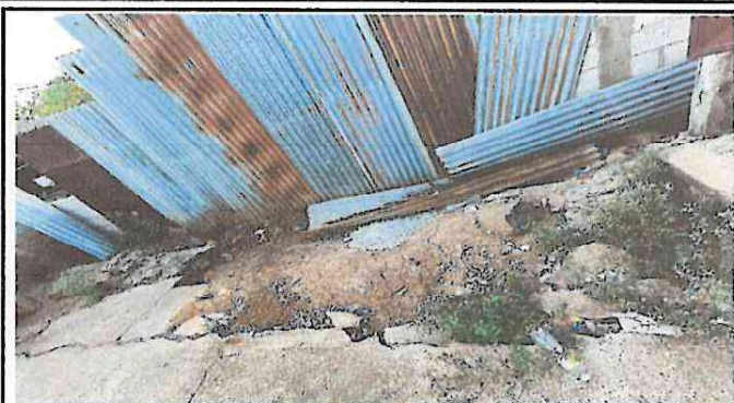
Foto 2: Reparación de piso de torta de concreto
