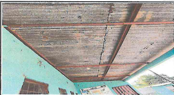
Foto 1: Sustitución de lámina por lámina troquelada
