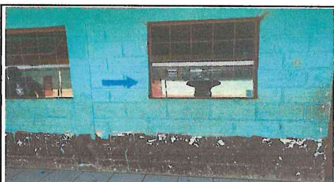
Foto 4: Pintura en muros exteriores e interiores
